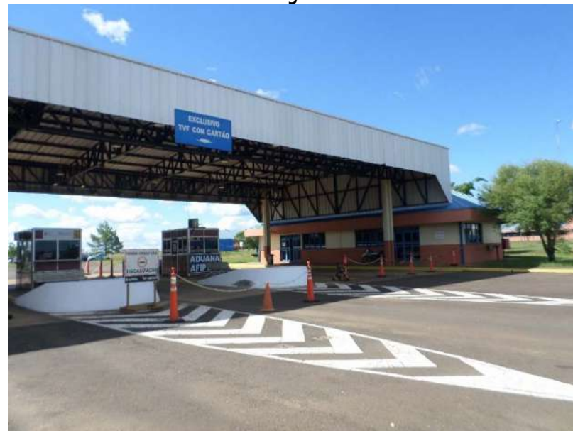
Pórtico no Pedágio de Automóvel
