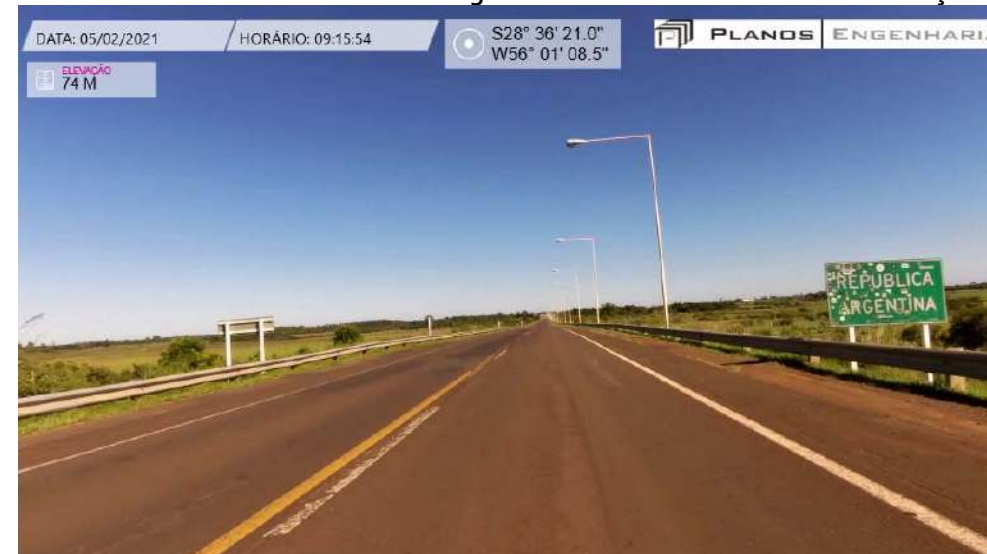
Placa no Início do Acesso no Lado Argentino em Péssimo Estado de Conservação
