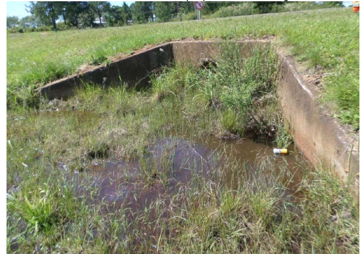
Saída do Bueiro Necessitando de Limpeza, no Acesso do Lado Argentino
