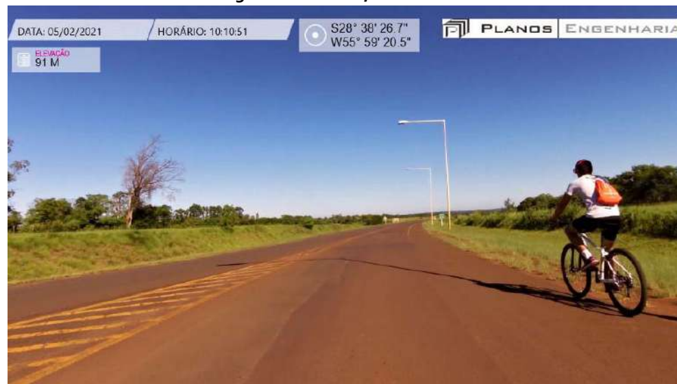
Zebrado com Desgaste na Pintura, no Acesso do Lado Brasileiro
