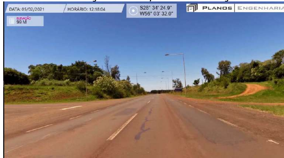
Faixas com Desgastes na Pintura, no Acesso do Lado Argentino
