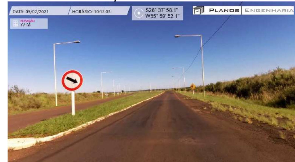
Ausência de Sinalização Horizontal no Acesso do Lado Brasileiro
