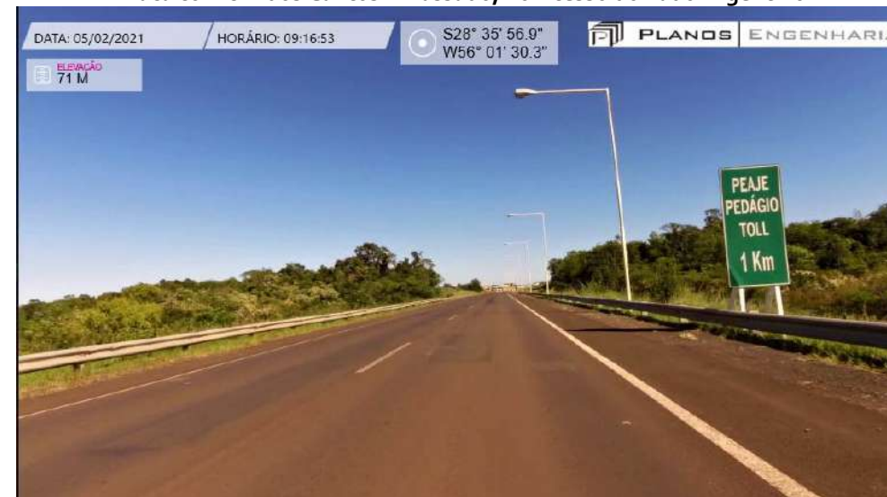
Placa com um dos Cantos Amassado, no Acesso do Lado Argentino
