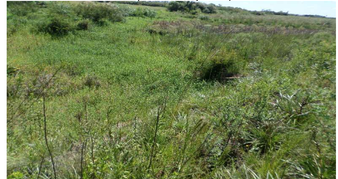
Saída do Bueiro Necessitando de Limpeza e Desobstrução da Ala, no Acesso do Lado Brasileiro
