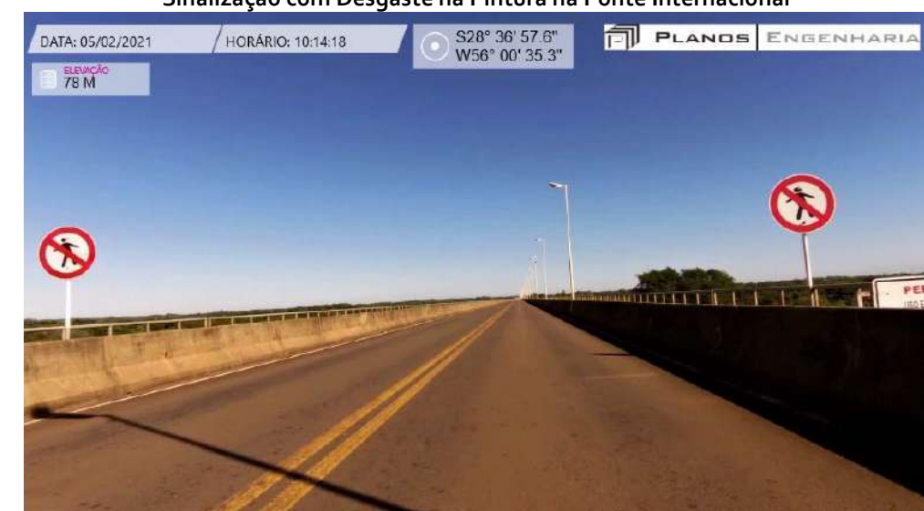
Sinalização com Desgaste na Pintura na Ponte Internacional
