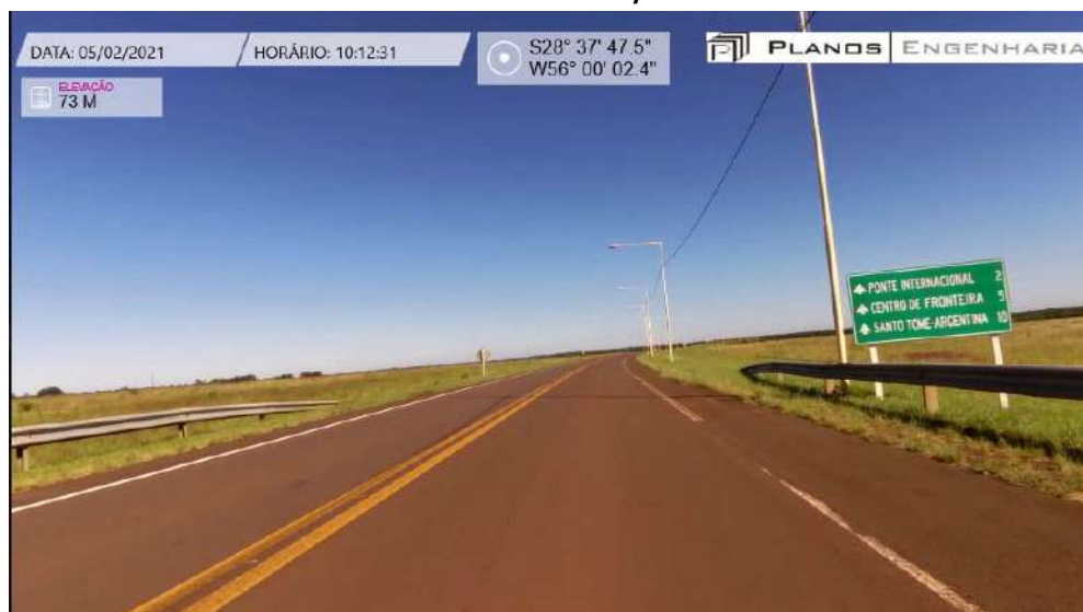
Placa Indicativa em Bom Estado, no Lado Brasileiro
