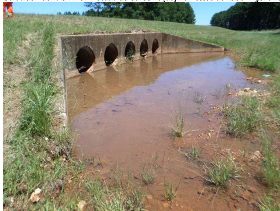
Saída do Bueiro em Bom Estado de Conservação, no Acesso do Lado Argentino
