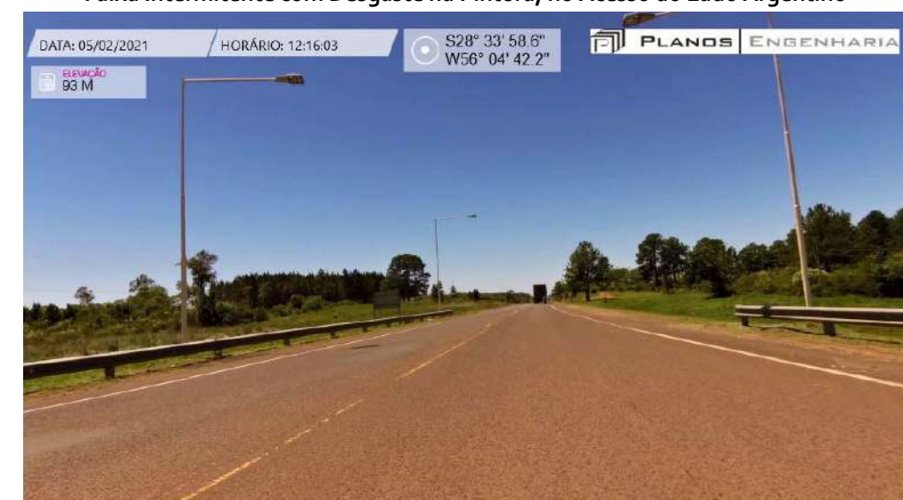
Faixa Intermitente com Desgaste na Pintura, no Acesso do Lado Argentino
